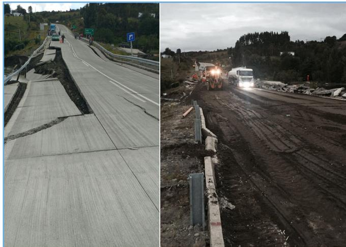
**Figura 6.27.** (a) Izquierda. Consecuencias del terremoto sobre el terraplén de la ruta 5 Sur. (b) Derecha. Rehabilitación del tránsito en el terraplén de la ruta 5 sur
