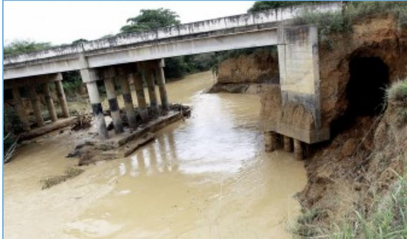
**Figura 4.27.** Socavación en estribo de puente sobre Río Aragua en Venezuela
